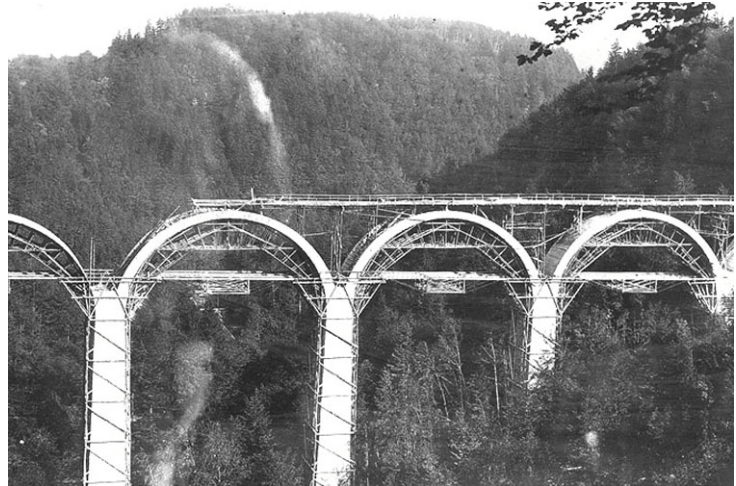
Der im Bau befindliche Viadukt. Fotoreproduktion. Abb. 1 (hus, 20. 8. 1997)
