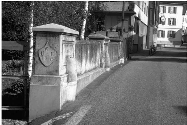
Die Brüstungsmauer weist die Jahreszahl 1846 auf. Abb. 2 (hus, 7. 5. 1998)
