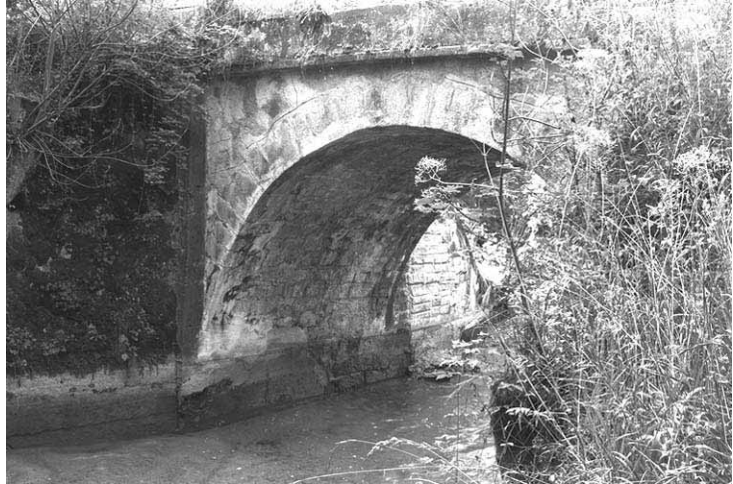
Der gefügte Brückenbogen (Blickrichtung Süden). Abb. 2 (hus, 20. 8. 1997)
