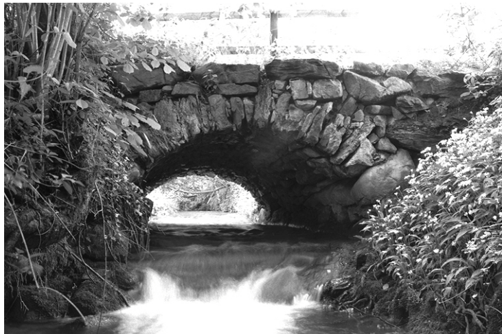
Die Brücke über den Haselbach bei Schliffi, südwestlich von Wissenbach. Abb. 1 (hus, 19. 5. 1995)
