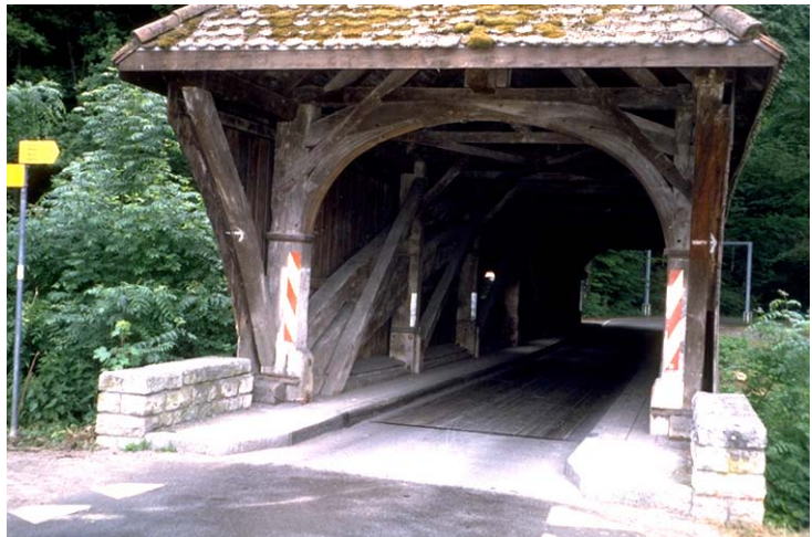
Ein weit vorgezogener Walm schützt die exponierte Zufahrtsseite. Störend sind die Heimatstil-Brüstungsmauern, die Reflektorstreifen und, im Hintergrund sichtbar, die beidseitigen Portalrahmen für die Höhenkontrolle. Blickrichtung West. Abb. 2 (do, 29. 5. 1998)
