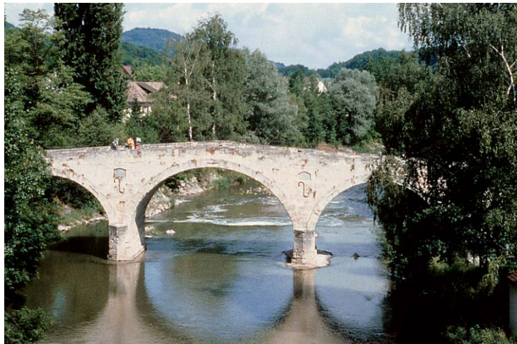
Von der neuen, flussaufwärts gelegenen Tössbrücke her gesehen treten die schlanken Flusspfeiler, die gut proportionierten Gewölbe und der ausgeprägte „Eselsrücken“ der „Römerbrücke“ deutlich hervor. Nicht sichtbar sind die langen Vorlanddämme. Blickrichtung Nordwest. (do, 17.6.98) Abb. 2
