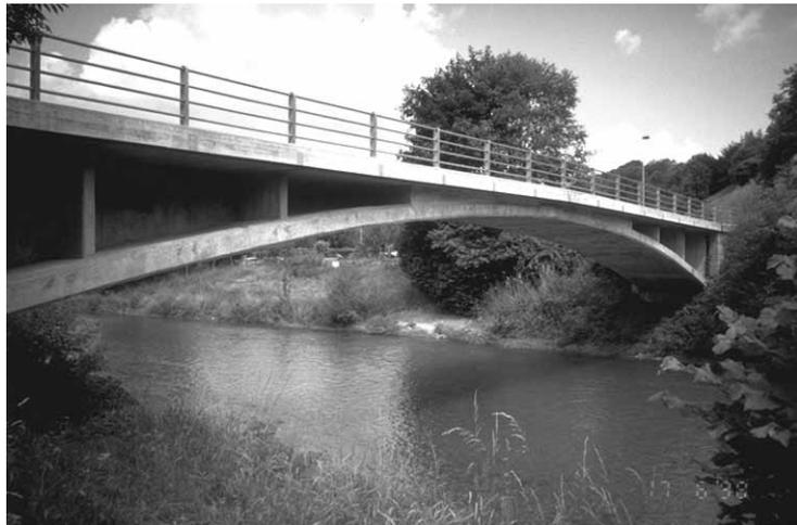
*In der Detailansicht lassen sich die originalen Bauteile (Gewölbepalte und Widerlager) von den neuen oder erneuerten Konstruktionselementen (Fahrbahnplatte, verstärkte Längsrippe, Querscheiben) unterscheiden.
