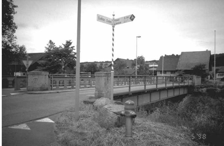
Bemerkenswert sind die profilierten Granitquader, welche die Brückenauffahrten flankieren, und die originalen Stahlrohrgeländer mit den Volutenabschlüssen.
