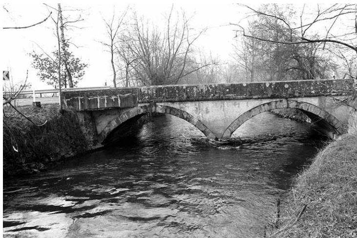
Die Lorzenbrücke an der Kantonsgrenze erinnert stark an einen Bau aus napoleonischer Zeit. Abb. 1 (TS, 13. 3. 1991)
