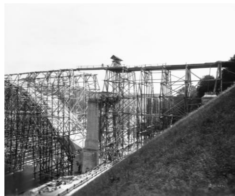
Grafik und Fotografie, z.B. vom Bau der Kornhausbrücke: BBB, FN.G.E.493
