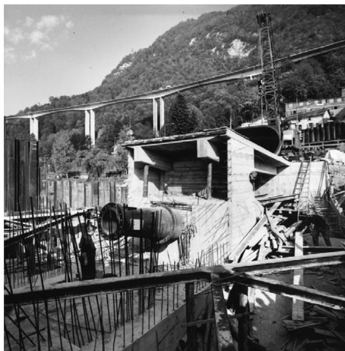
FMHL - Centrale de Veytaux - Construction de la tête aval de la vanne de vidange au Léman, ~1970.
