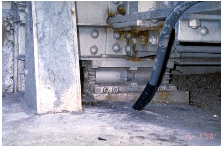
Detailansicht des Rollenlagers am Nordufer. Abb. 4 (do, 5. 3. 1998)
