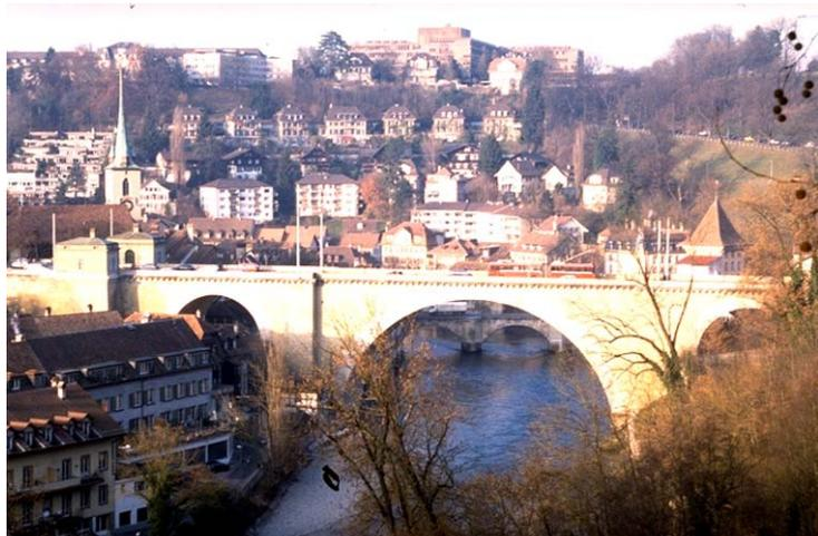
Gemäss FURRER (1984: 18) wird der mächtige Flussbogen beidseitig von den massigen Widerlagern mit den kleineren Landbogen gehalten. Die Widerlager ihrerseits schliessen an die Dämme an, die landseitig aufgeschüttet werden mussten. Diese drei Elemente – Bogen, Widerlager, Damm – sind im Grundriss durch ihre zunehmende Breite ablesbar. Der Damm auf der Seite der Stadt ist rund 150 m lang, die Stützmauern bestehen aus Sandsteinquadern.
