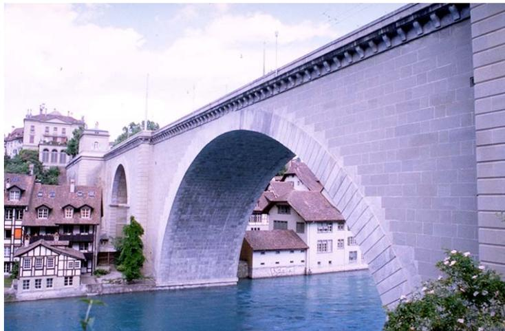
Für den Bau des Flussbogens, der Einfassung der Landbogen, der Brüstungen sowie der Verkleidungselemente wurde Granit, ansonsten Sandstein verwendet (Abb. 5, 6). Die massiven Brüstungen von 80 cm Höhe und 50 cm Breite lagern auf geschweiften Granitkonsolen. Die Dämme werden gestalterisch von je zwei eingeschossigen Sandstein-Pavillons abgeschlossen, die nach der Erstellung der Brücke nur eine kurze Zeit ihrer vorgesehenen Funktion als Zollhäuschen gedient haben (Abb. 7).
