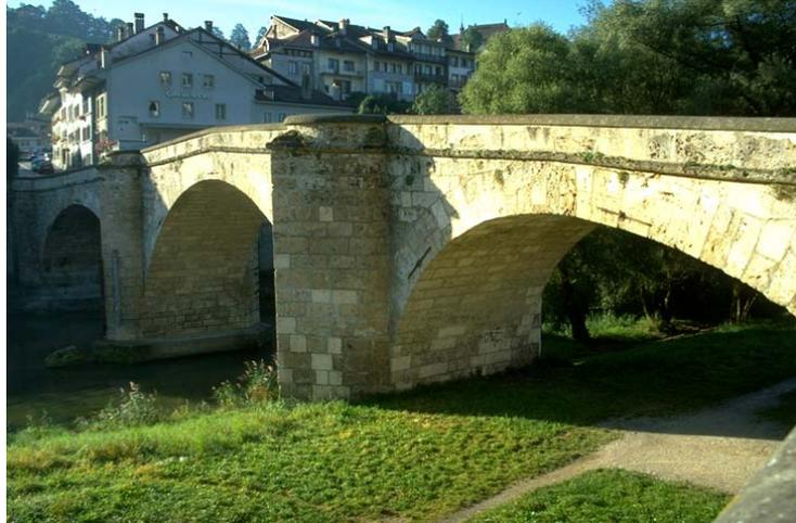
FR 4.2 traverse la Sarine par le pont de Saint-Jean. Il comporte trois arches formées de gros blocs de tuf et de grès. Légèrement bombée, sa surface est recouverte de pavés cubiques. Le tablier est délimité par deux murs aux bords arrondis. A Planche-Supérieure, le segment se prolonge par FR 4.2.2.
