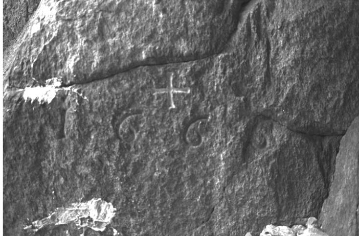
2) Vermutetes Widerlager der "Twärrenbrücke" und bearbeitete obere Fläche eines Auflagers; Spuren, die möglicherweise von Menschenhand stammen. Die oben erwähnte Theorie der beidseits aufliegenden Balken basiert nicht zuletzt auf dieser Felsnische und Abplattung auf dem gut verankerten Felsblock.
