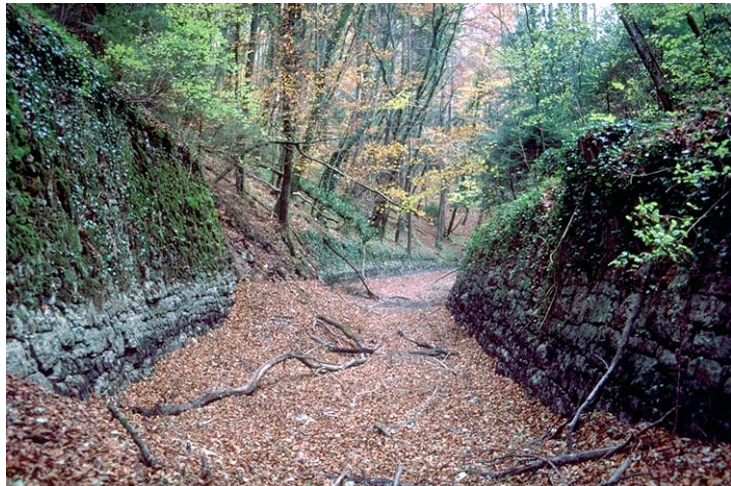
Cluse d'Entreroches où passait le canal dont on peut encore voir les murs de soutènement. Fig. 3 (nab, 3. 3. 2002)
