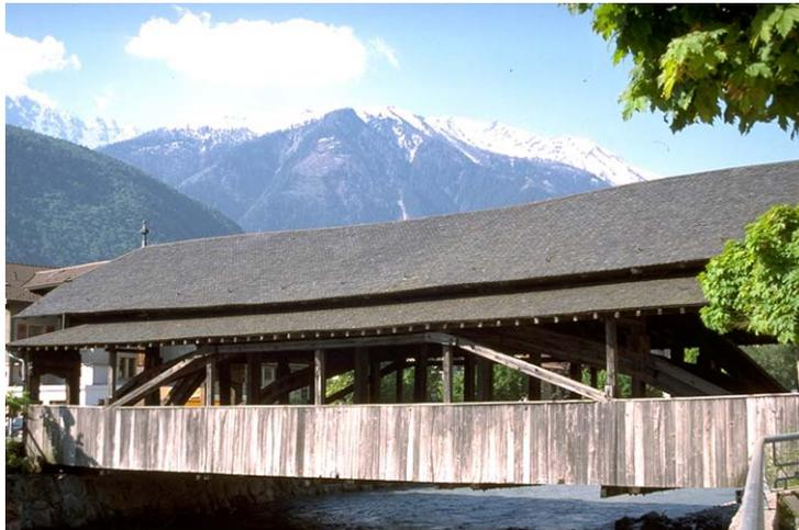
La chaussée est double (2 x 3.2 m), bordée par deux passages piétonniers de 1.4 m de large chacun que l'on a ajouté lors du renforcement des arcs et des montants en 1948. La portée est de 24 m, la longueur totale de 27 m et la pente de 1.5 %. Le tablier surplombe le lit de la Dranse de 3.5 m. La hauteur de passage est de 4.2 m.
