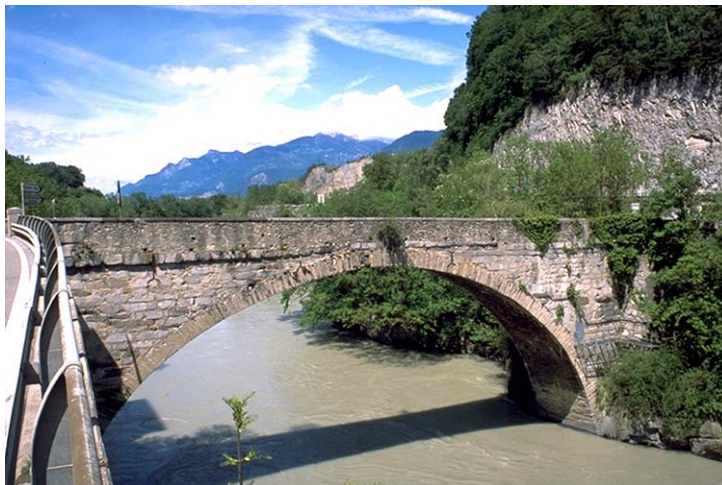
Pont situé en face du château de Saint- Maurice Fig. 18 (SA, 12. 5. 2003)
