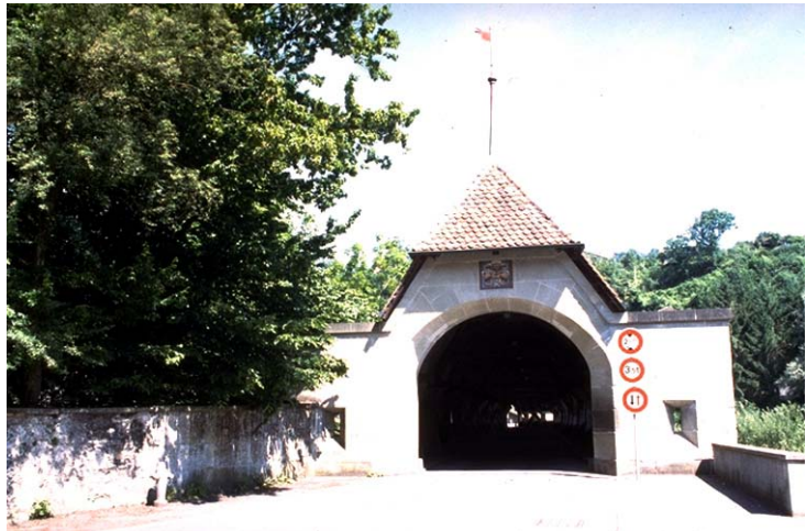
Das gemauerte Südportal mit dem «Bern-Rych-Wappen». Abb. 4 (GS, 20. 6. 2001)
