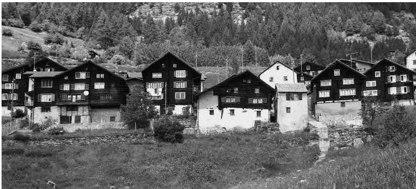
14 Vista da sud est di frontoni in legno
