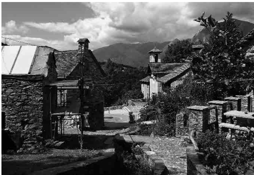
3 Panoramica da sud est: edifici abitativi e utilitari
