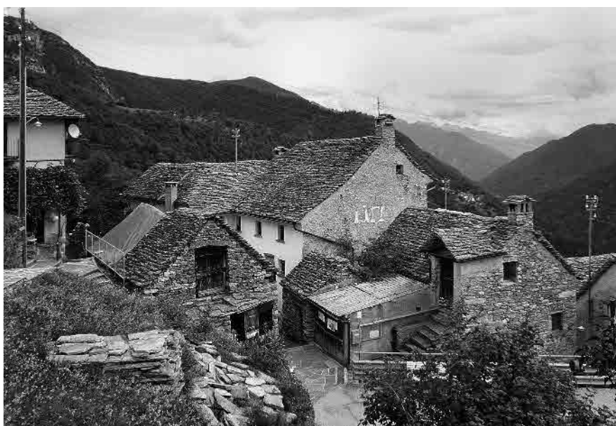
10 Il nucleo secondario di Culunz, abitativo e utilitario
