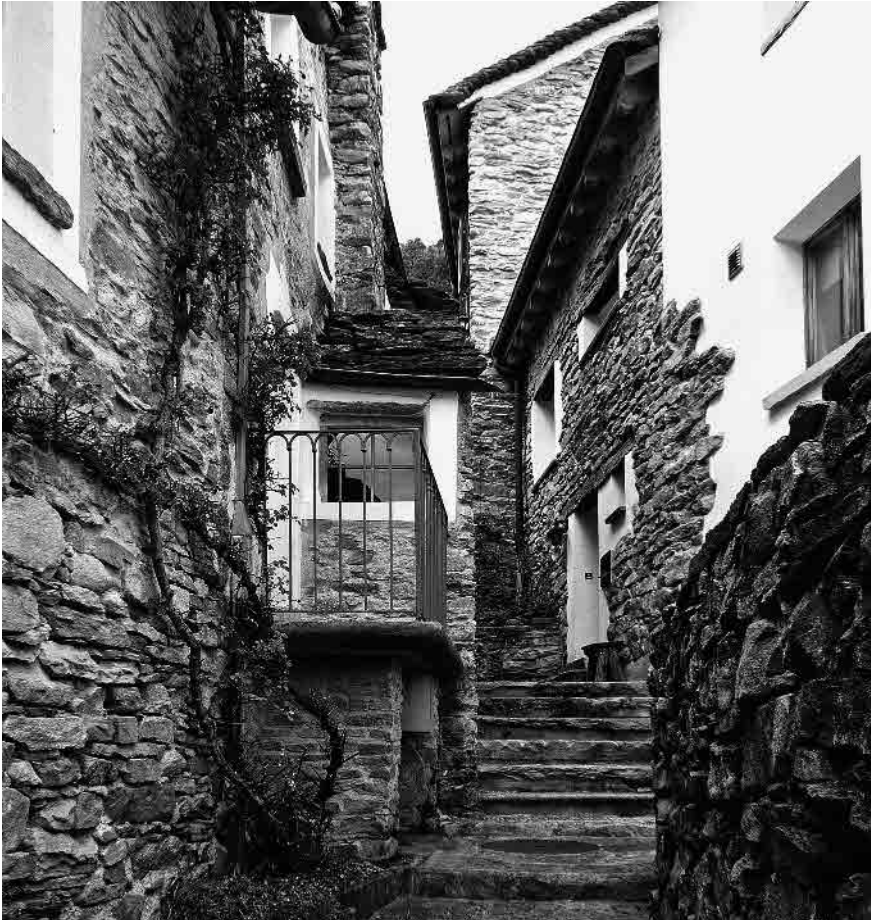
5 La muratura a vista dominante
