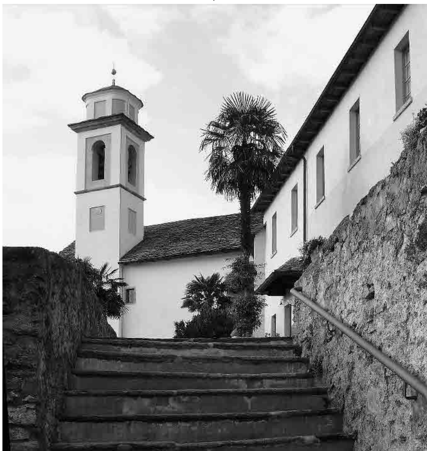
2 Accesso alla terrazza aperta verso valle
