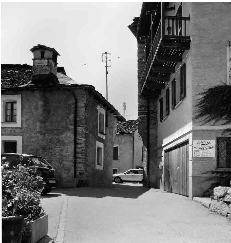
11 Ampliamento e strettoia del vicolo interno
