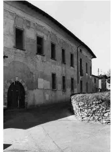
10 Lato ovest del Palazzo Lighillini
