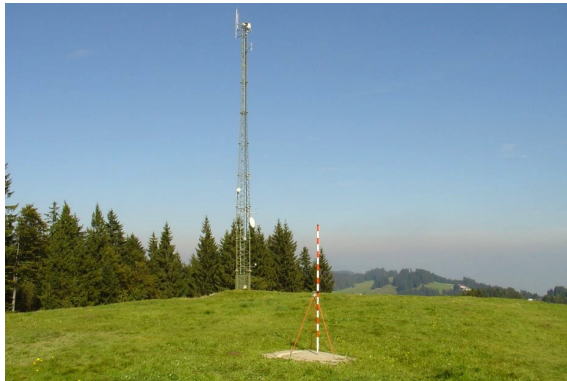
2013: Betonsockel neigt sich 5% Richtung SSE
